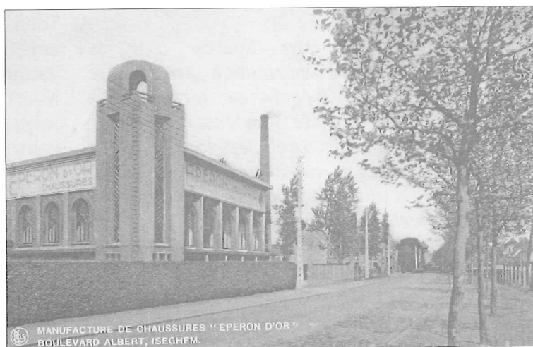
Het gebouw tijdens het interbellum. (foto in privébezit)
